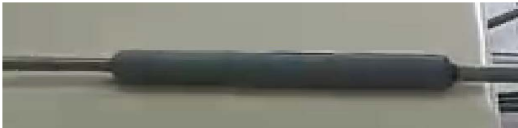
Figura 74 – Detalhe da instalação da manta de recomposição da cobertura em uma emenda
