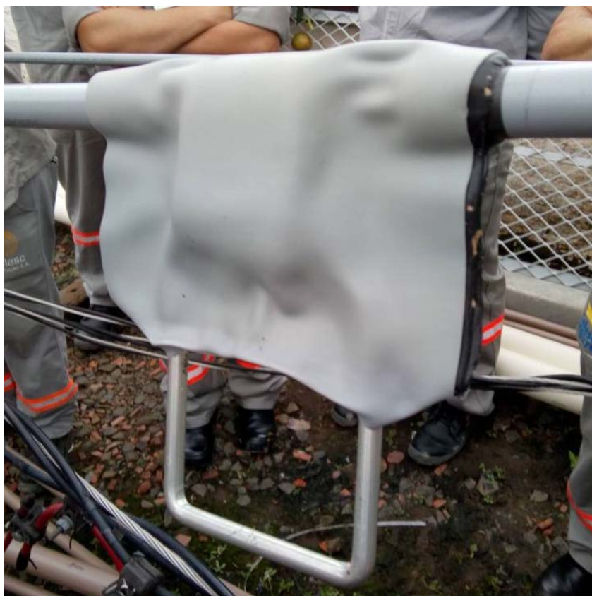
Figura 73 – Ddetalhe da instalação da manta de recomposição da cobertura em um adaptador estribo cunha
