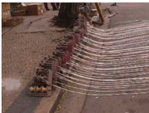
Preparação das carretilhas para cabo – método cortina
