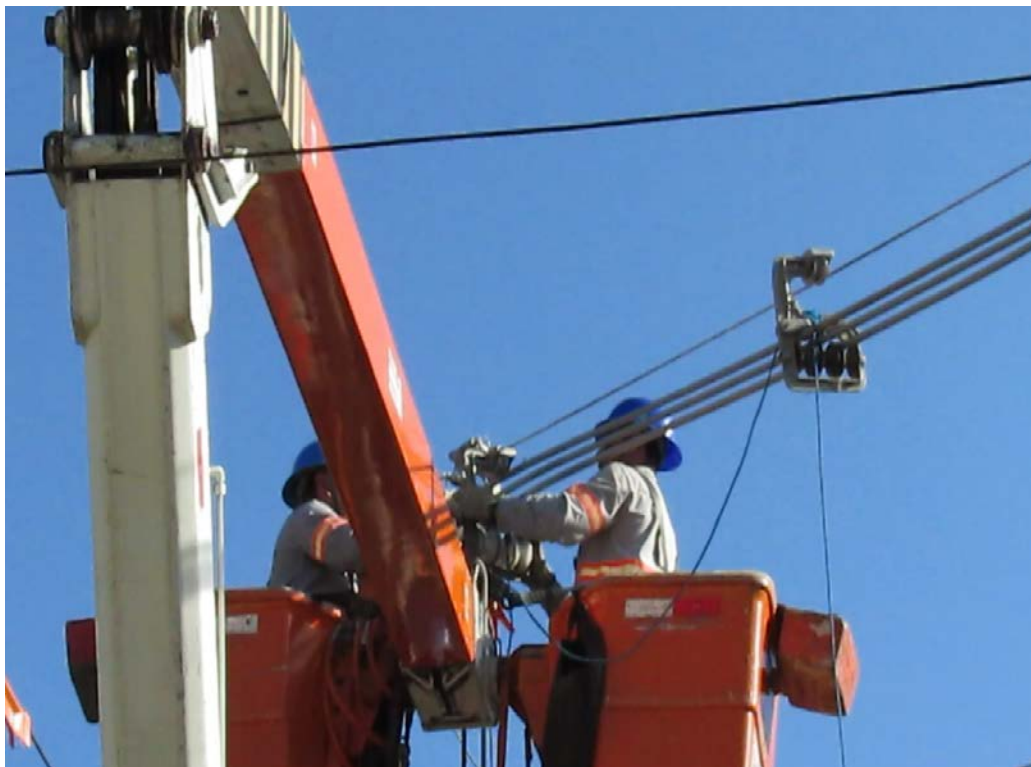
Montagem das carretilhas
