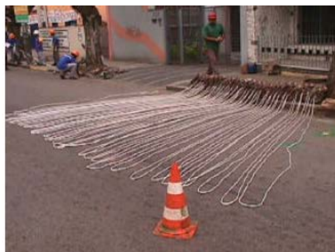
Preparação das carretilhas para cabo – método cortina
