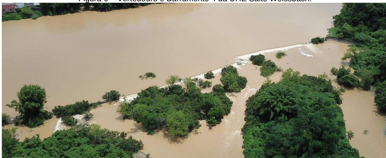
Figura 6 – Vertedouro e Barramento 4 da UHE Salto Weissbach.
