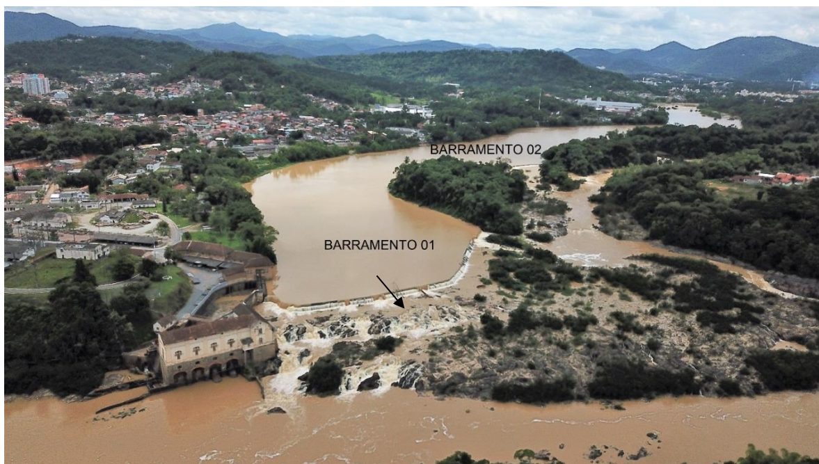
Figura 4 – Vertedouro e Barramento 1 e 2 da UHE Salto Weissbach.
