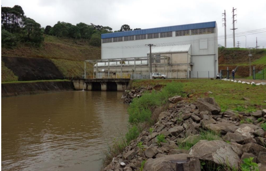
Figura 8 - Casa de força e Canal de fuga da Tomada d'água 02 da UHE Pery.
