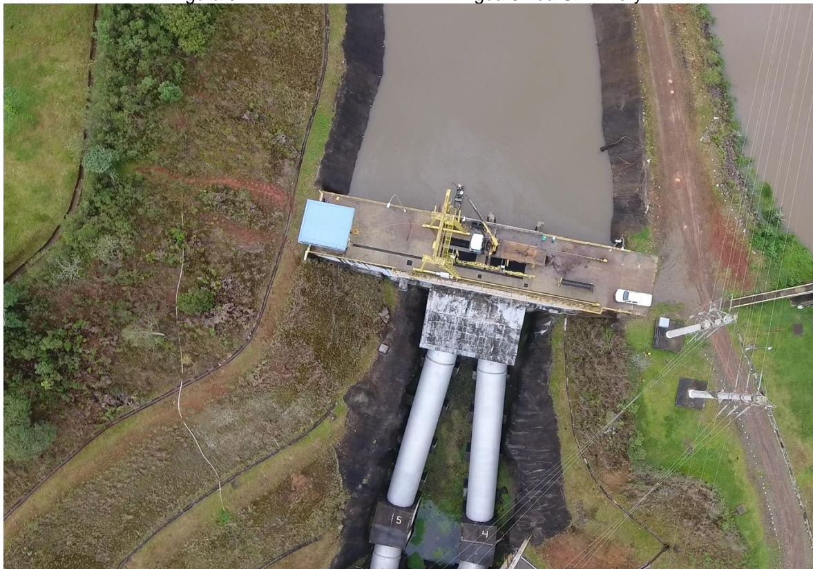
Figura 5 – Barramento e Tomada d'Água 02 da UHE Pery.
