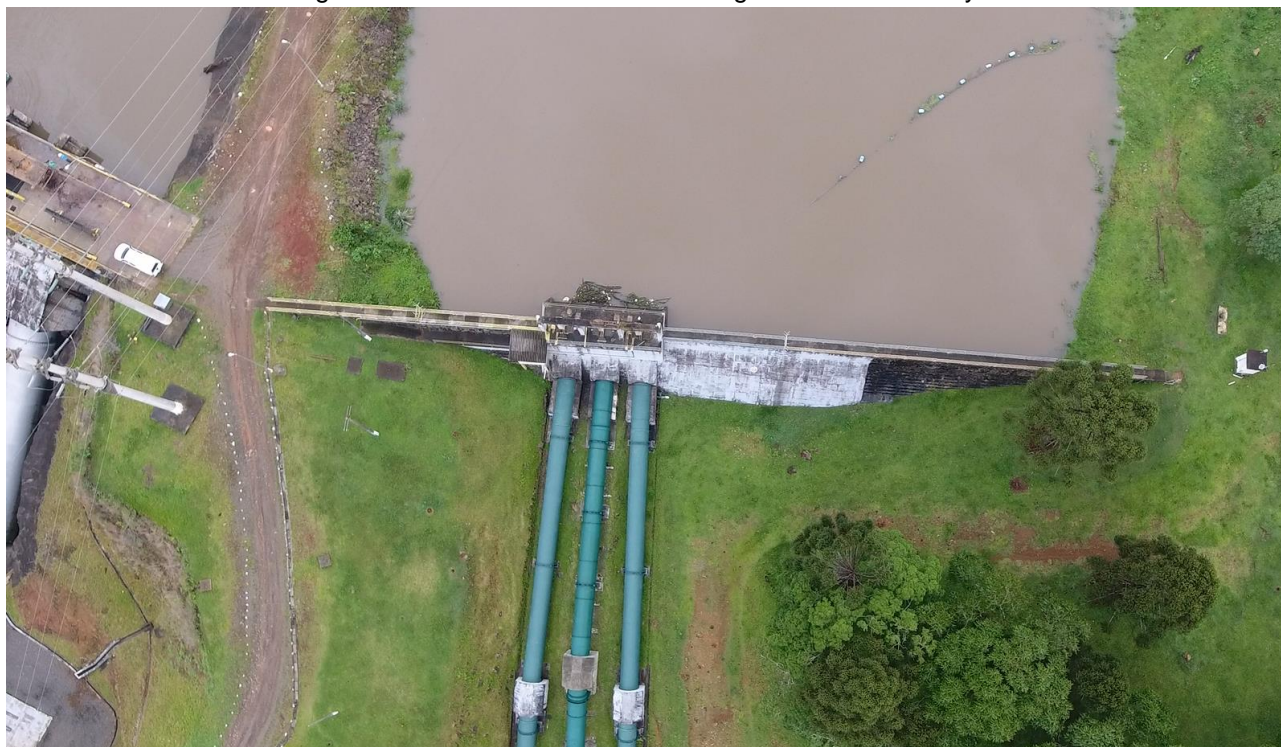
Figura 4 – Barramento e Tomada d'Água 01 da UHE Pery.
