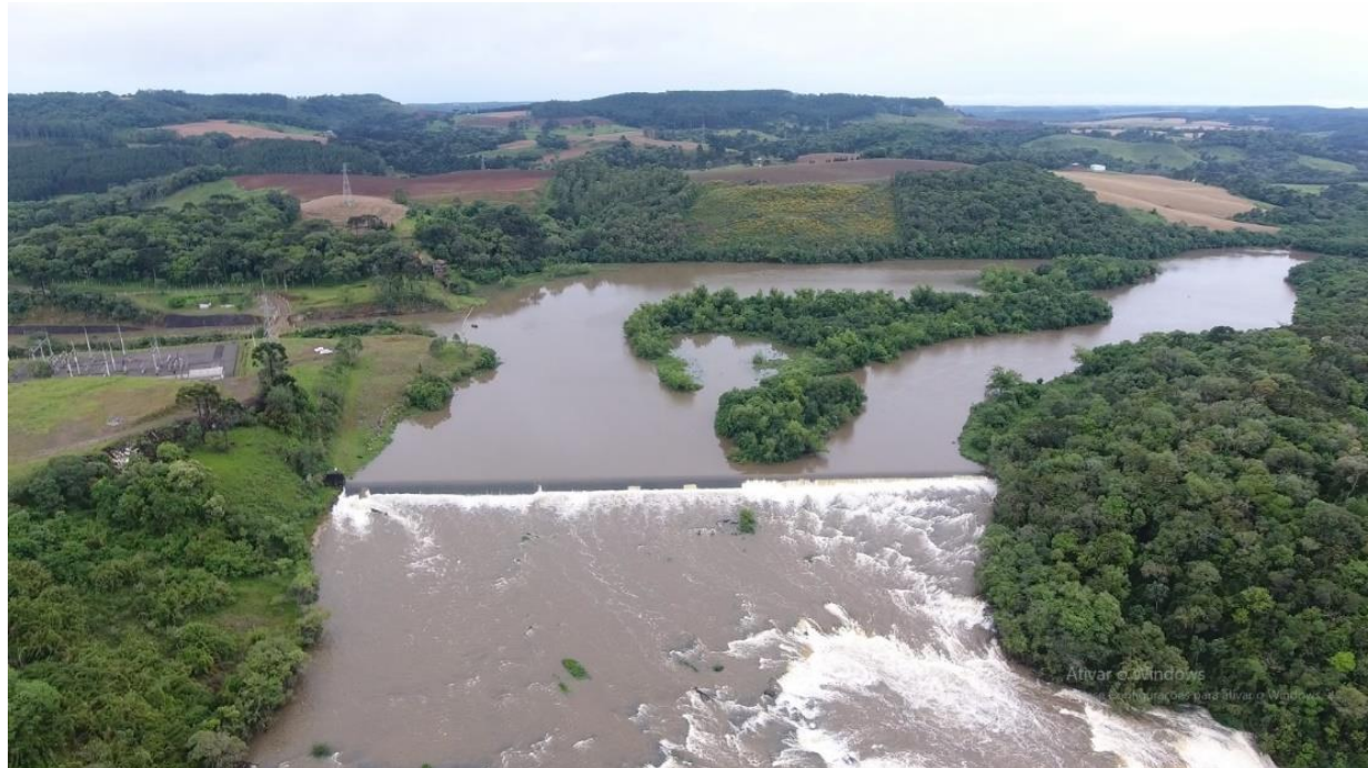
Figura 3 – Barramento Principal da UHE Pery
