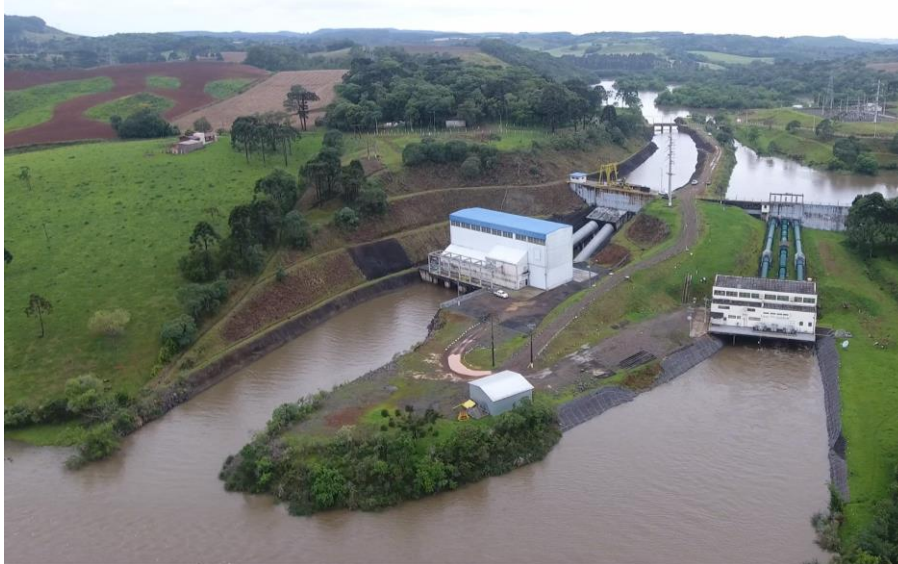
Figura 9 - Vista Geral das Casas de força e Canais de Fuga da UHE Pery.
