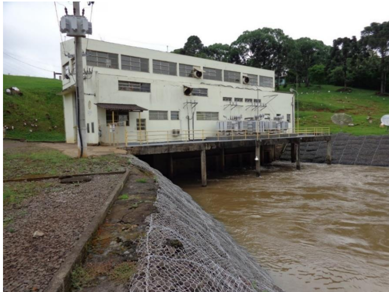
Figura 7 - Casa de força e Canal de fuga da Tomada d'água 01 da UHE Pery
