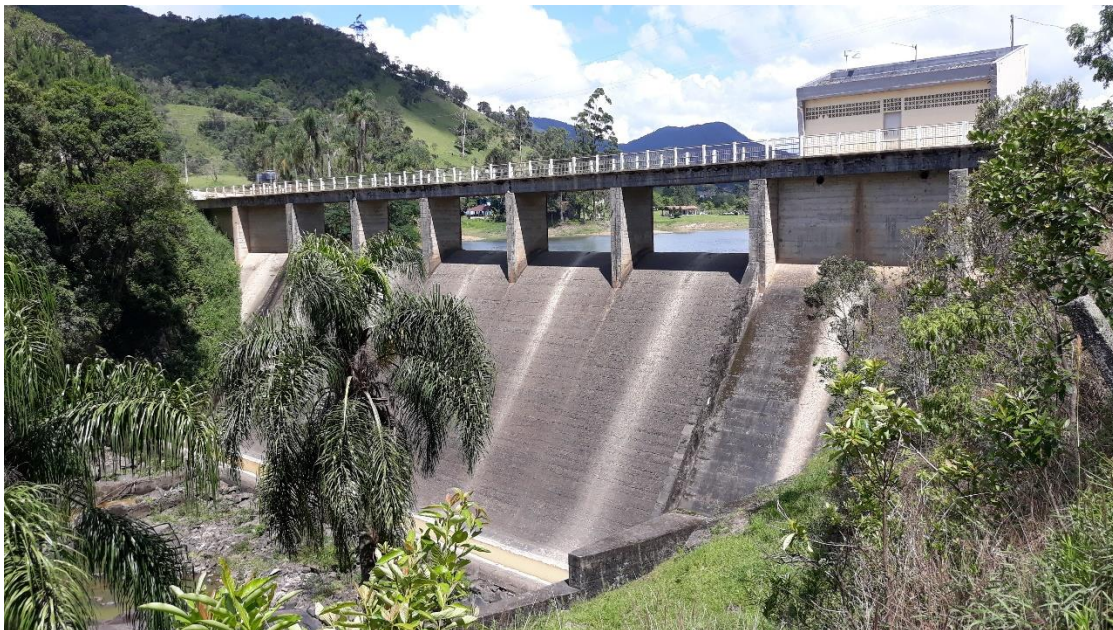
Figura 8 – Vista do vertedouro da UHE Garcia
