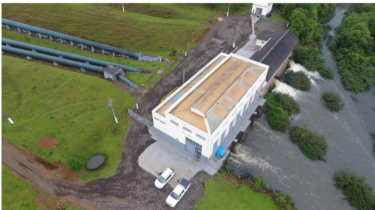
Figura 12 - Casa de Força da GCH Caveiras
