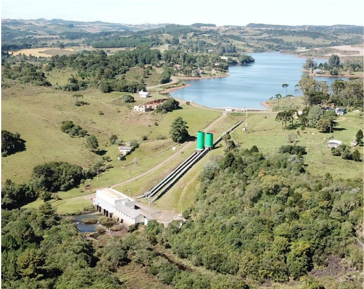
Figura 4 - Vista do Arranjo Geral da Tomada d'água da CGH Caveiras
