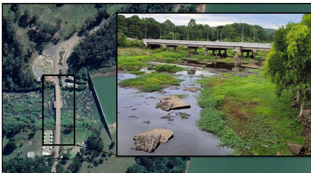
Figura 20 – Composição da Ponte logo a jusante da barragem da CGH Caveiras.
