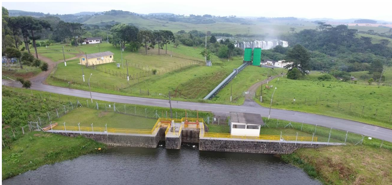
Figura 10 – Vista a Montante do Barramento de Tomada d'água da CGH Caveiras.
