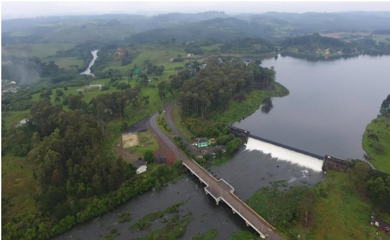
Figura 2 – Vista do Arranjo geral do aproveitamento da CGH Caveiras – Barragem Principal
