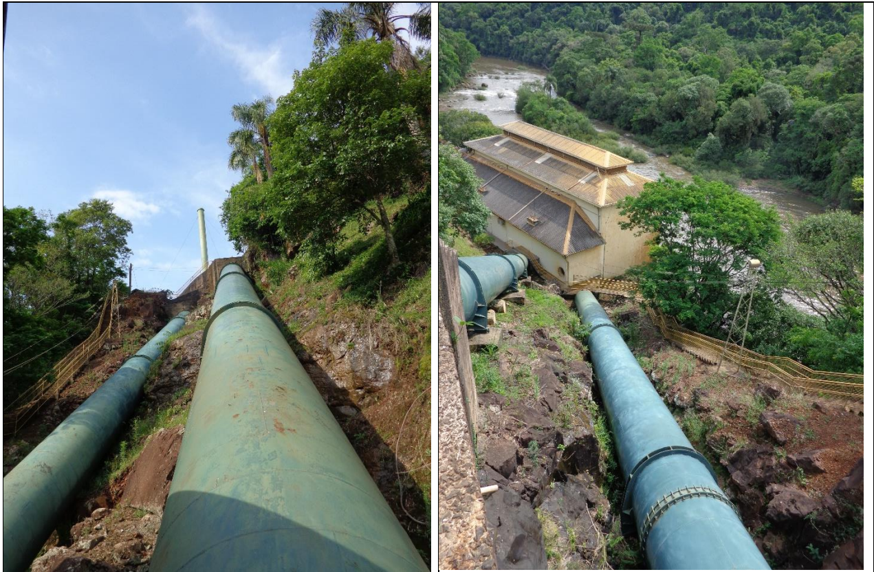
Figura 12 - Conduto forçado das unidades 3 e 4 e Casa de Força 02.
