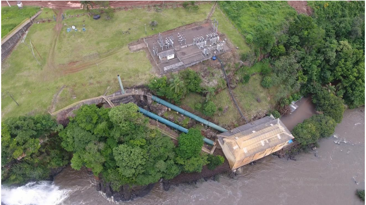
Figura 14 - Casa de Força 01.
