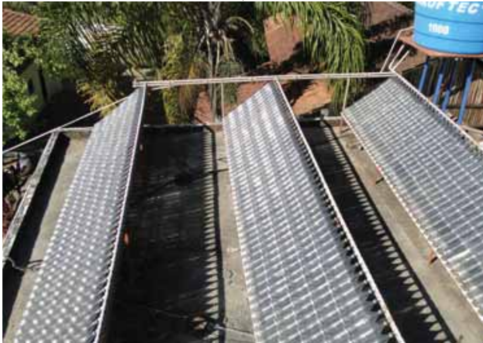
Aquecedores solares construídos com garrafas pet e outros materiais reutilizáveis
