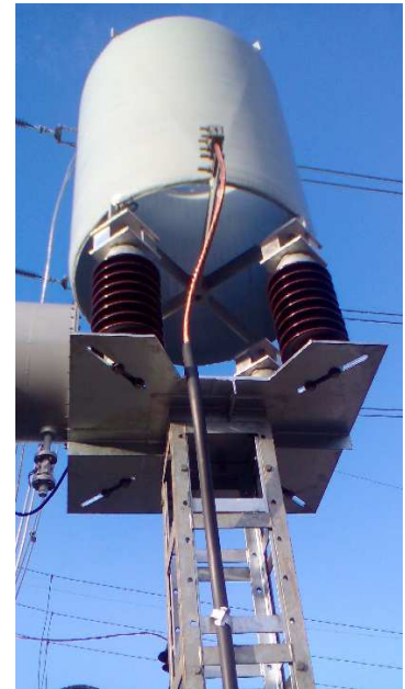
Foto 1: Estruturas Montantes Inferior e Superior encaixadas Foto 2: Placa de Adaptação
