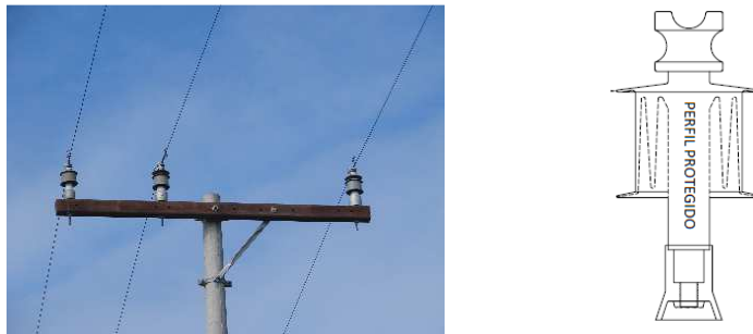
Figura 2 - Rede convencional com isoladores híbridos
