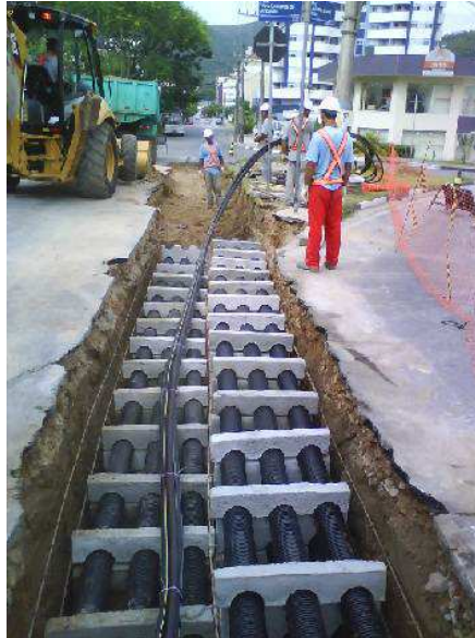
Figura 13 - Banco de dutos em rede subterrânea
