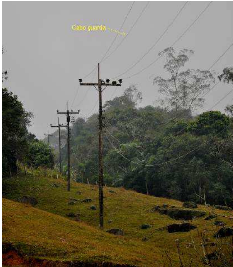
Figura 15 - Rede convencional com cabo guarda
